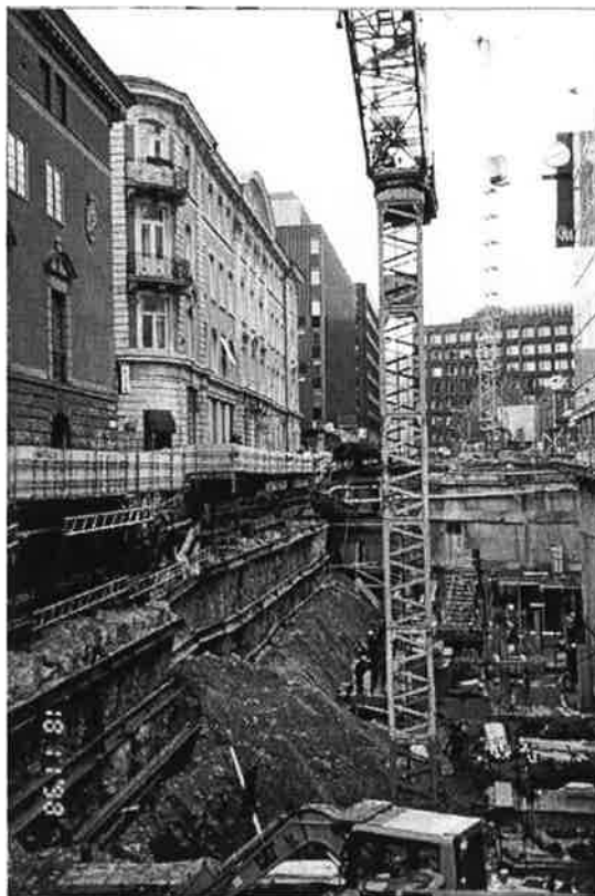
Bild 18. Vy över arbetsplatsen efter det att stödkonstruktionen färdigställts
