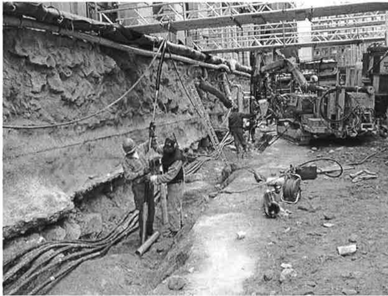
Bild 14. I förgrunden ses dubbelmanschettutrustning för vattenförlustmätning, i bakgrunden borrhning för jetpelararmering, borrhigg Atlas Copco 712.
