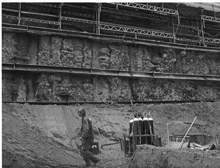
Bild 20. Vy över färdig temporär stödkonstruktion längs kv Brunkhalsen
