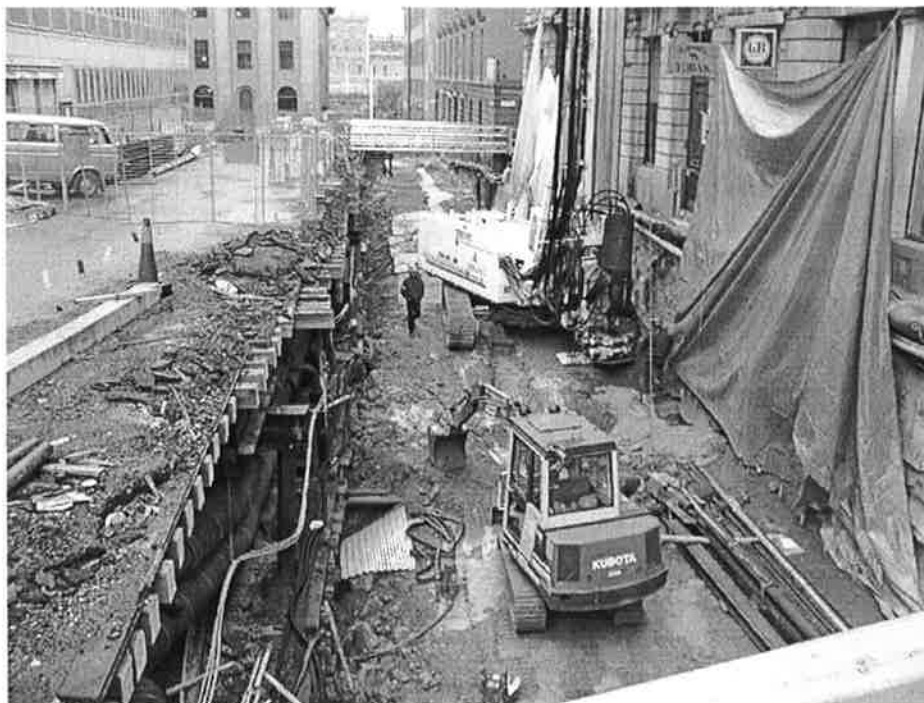
Bild 5. Installation av jetpelare vid Brunkebergstorg
