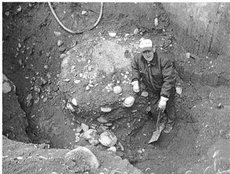
Bild 7. Framschaktad produktionsjetpelare, \phi \sim 1300 mm
