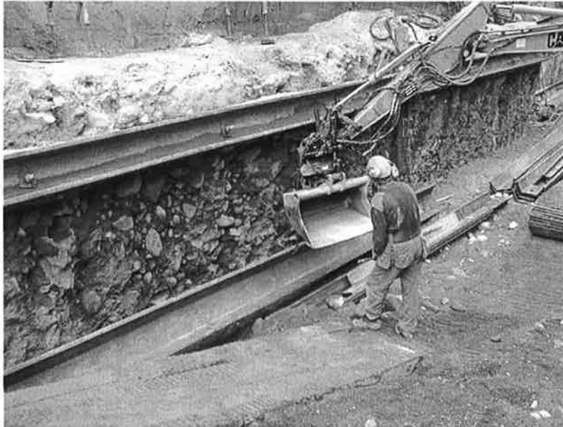
Bild 16. Montering av hammarband
