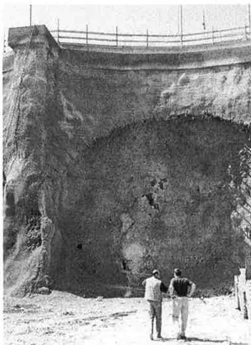
Bild 25. Vertikal jetpelarkonstruktion för jordtunnelanfang
