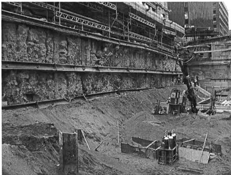
Bild 17. Schakt utförd till schaktbotten
