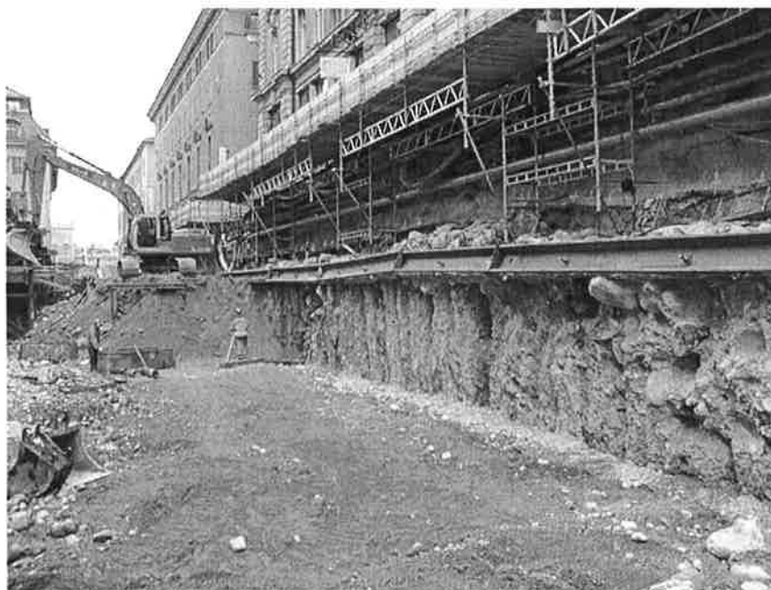
Bild 19. Schakt ned till andra hammarbandsnivån. Jordmaterial ensartat sand och grus i detta område, Brunkhalsen's södra tredjedel.
