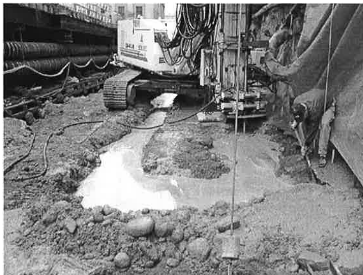
Bild 9. Överskottsmassorna leds bort i temporärt dike under pågående jetting
