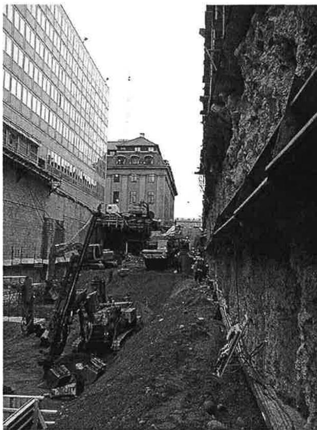
Bild 12. Jetpelarväggens raket efter färdig schakt
